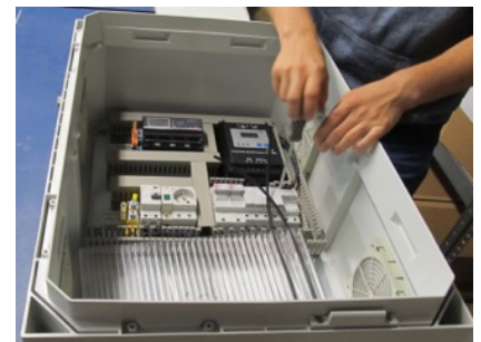
Montaż wyposażenia w szafce
