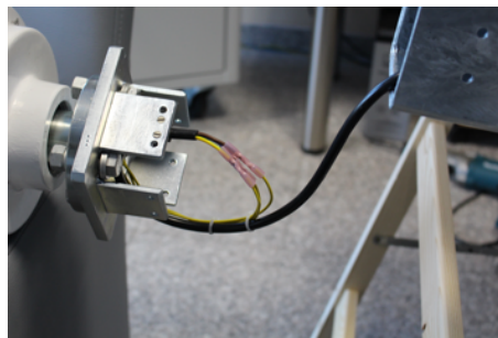
Podłączenie elektryczne generatora
